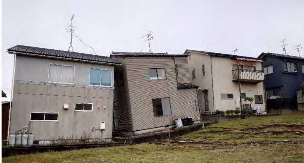
(能登半島地震の建物被害の例: 愛知工業大学横田 2024年3月3日撮影)
