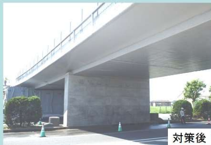
耐震補強の施工例
