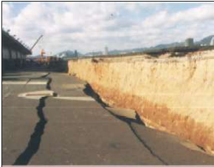
ポートアイランドの護岸背後の陥没
