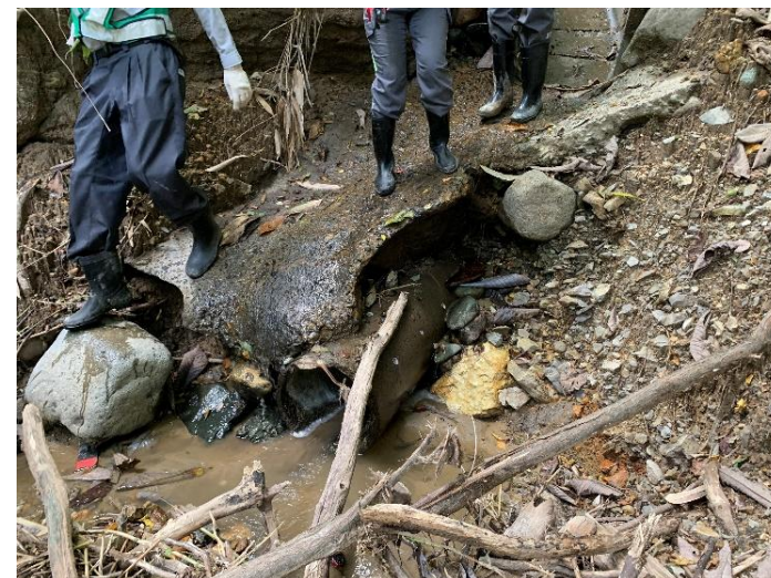
盛土中腹部の暗渠排水
