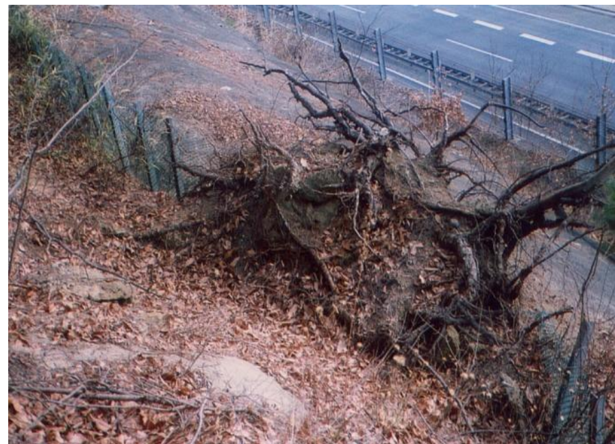
樹木の倒れによる根返り箇所
