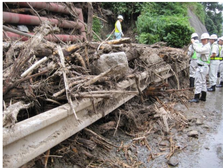
災害発生時に転石や流木を捕捉
