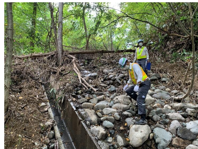
盛土排水対策工(良質材で置き換え)
