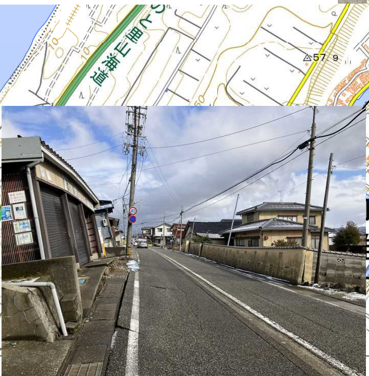
⑤砂丘側の建物の変形：道路側でせりあがっている
