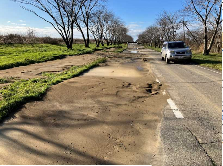
⑬液状化に伴う噴砂、堤防の沈下
