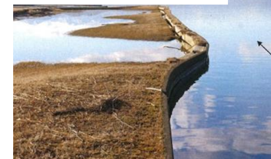
東部承水路（湖東） 堤防沈下 L=3,757m
