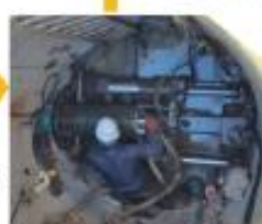
④ 集水管設置状況 鋼管内に集水管を設置
