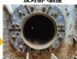
③ 鋼管が反対側へ到達
