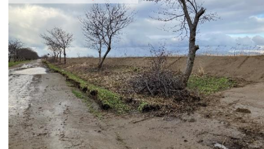
東部承水路（湖東） 堤防沈下 L=3,757m
