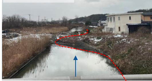
西部承水路（宮坂～西荒屋） 護岸損傷（傾斜） L= 約3km
