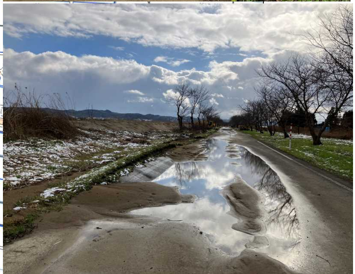
⑫東部承水路沿いの液状化被害：堤防沈下のため嵩上げ
