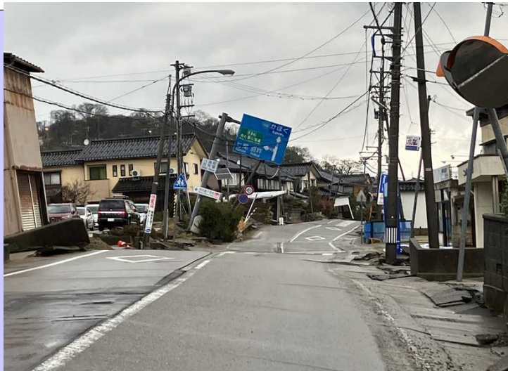
③西荒屋小学校前：道路の変形、道路標識の傾き
