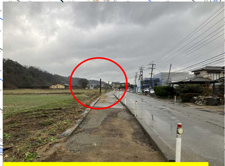
②電柱の沈下：左側の電柱が1～2m地中に埋没
