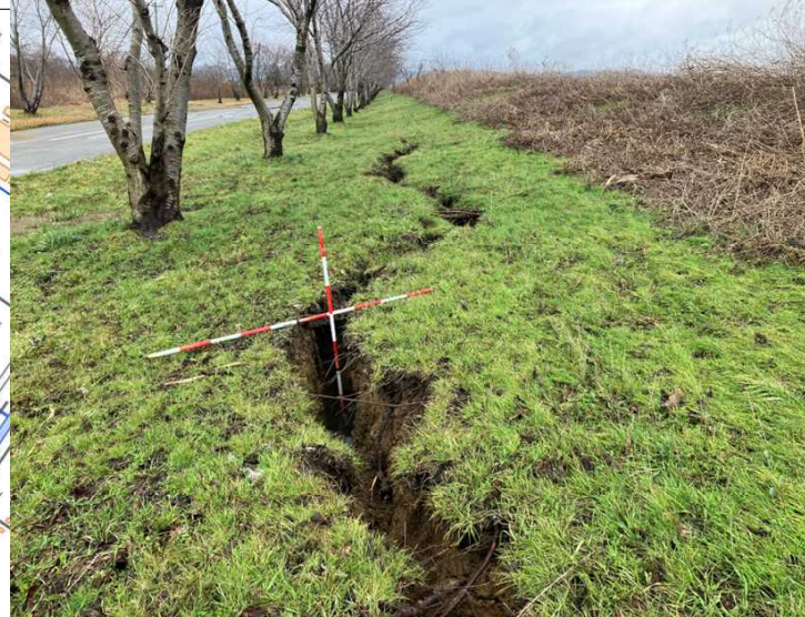
⑭液状化に伴う堤防の沈下、亀裂
