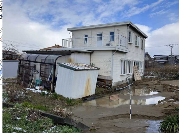
建物周辺の液状化被害（噴砂、沈下）
