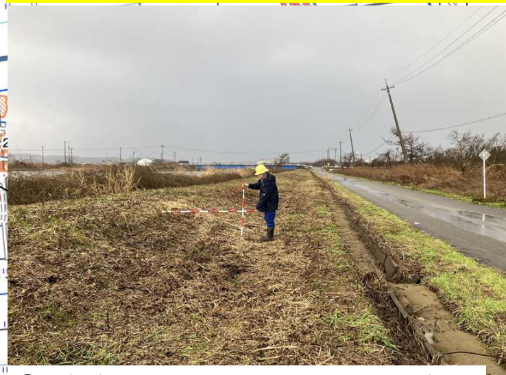
⑪堤高が0.6mと著しく低く、越水の恐れがある
