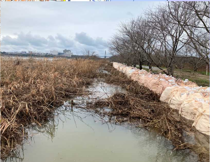
㉒正面堤防：堤防の沈下により越水し、応急対策で土嚢を設置 河北潟の水が土嚢の隙間から漏水し、管理道路に流入
