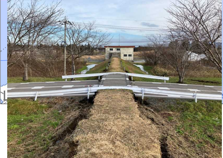
⑭道路の沈下：残存部は金沢排水機場からの排水
