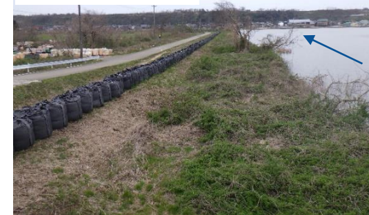
東部承水路（川尻 漕艇場付近） 護岸損傷 L=140m
