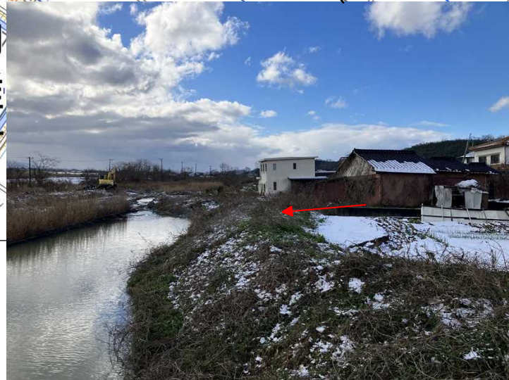
⑥側方流動による河道の閉塞：建物が10m程度移動
