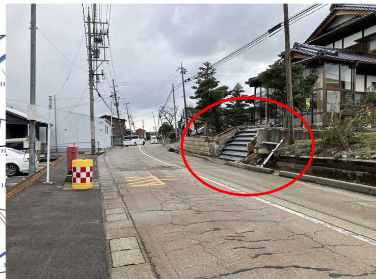
⑩宅地の被害状況：階段が押出され急勾配になっている
