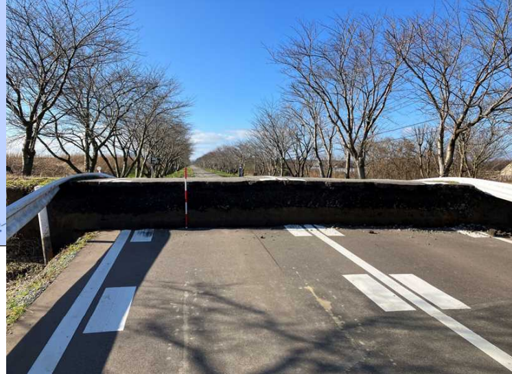
道路の沈下により1mの段差が生じ、一時通行止めとなった
