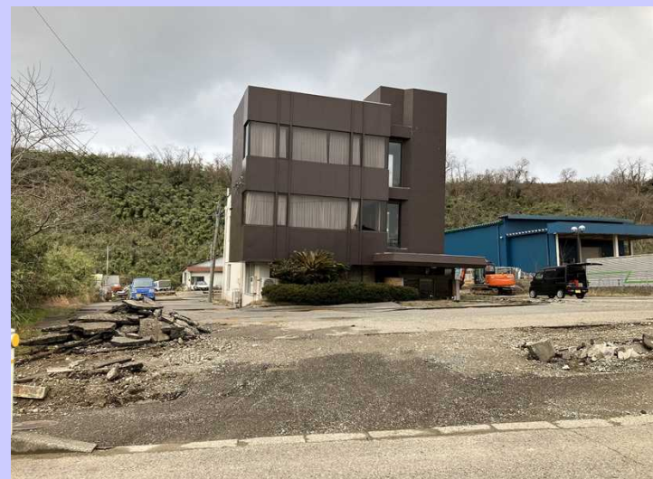
①建物の沈下：液状化により1階の半分が地中に埋没
