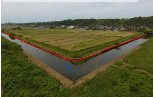
西部承水路（宮坂～西荒屋） 護岸損傷（傾斜） L= 約3km
