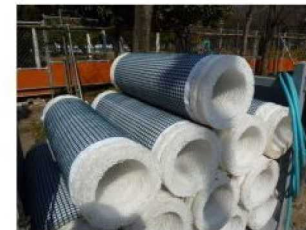
ドレーン管（挿入前、立体網目状集排水管に透水シート、ジオテキスタイルを巻いた状況）
