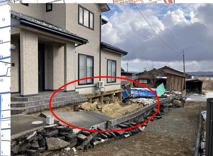
⑦周辺地盤の沈下により改良体が露出している
