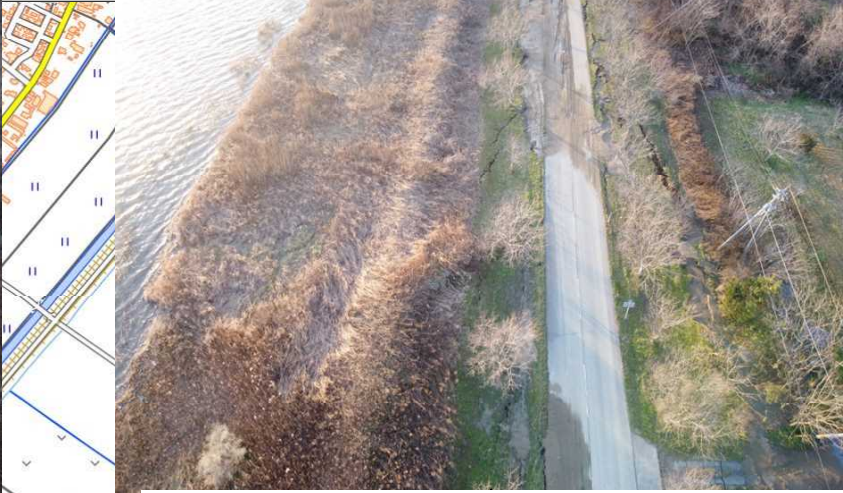
⑱液状化に伴う堤防の沈下、噴砂、亀裂（空撮）
