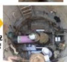
④ 集水管設置状況 鋼管内に集水管を設置
