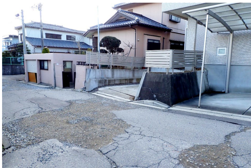
比較的変位が大きかった箇所は舗装や住宅外構が損壊
