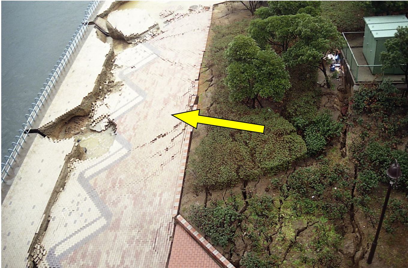
ポートアイランドの岸壁の側方流動で地割れが発生（阪神淡路大震災）
