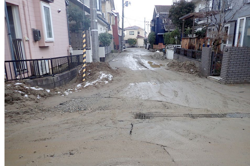
住宅街を覆う噴砂， 舗装路面損壊， 建物の不同沈下
