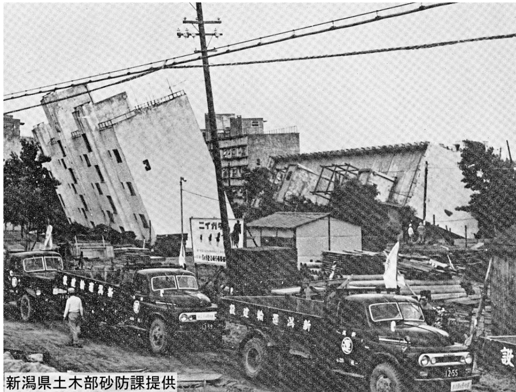
鉄筋コンクリート造建築物の沈下・傾斜 (新潟地震 川岸町県営アパート)
