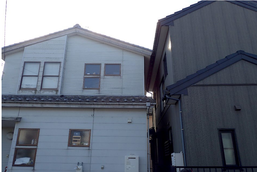
住宅の不同沈下 隣接建物でよくある例
