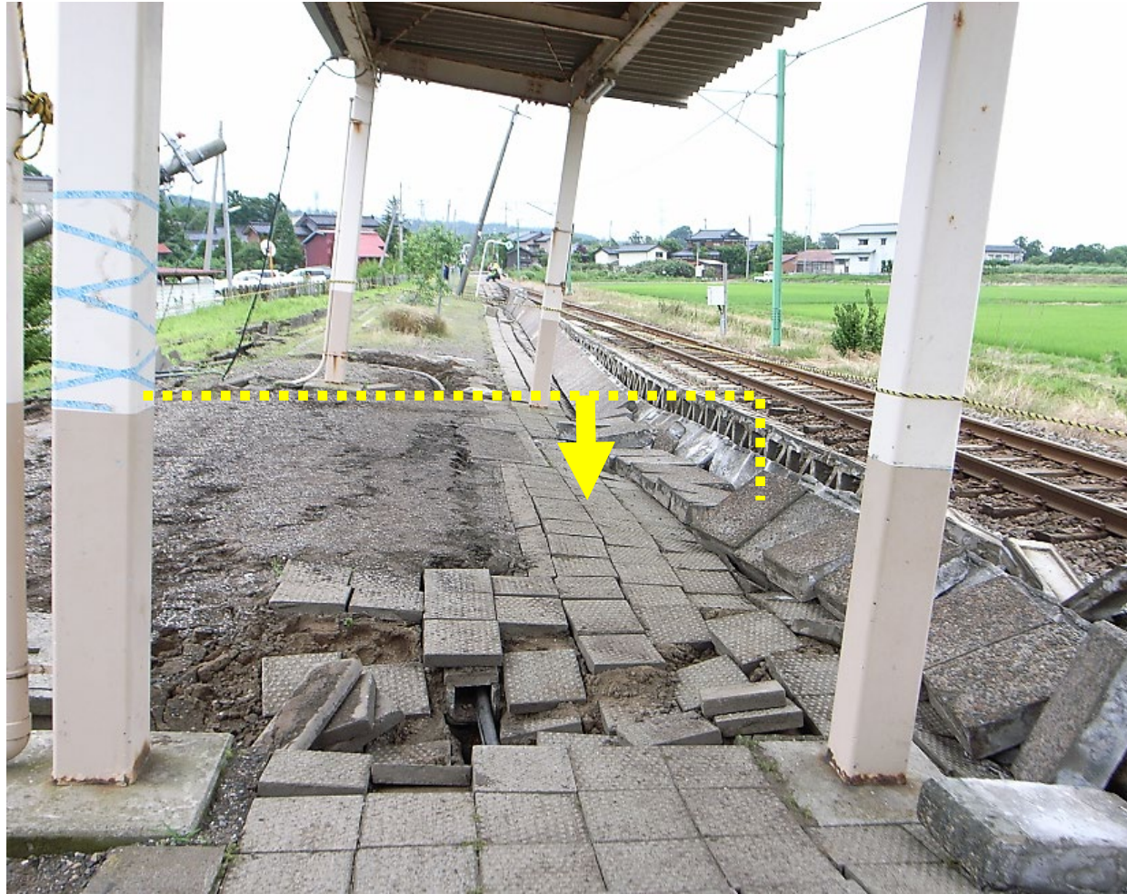
越後線荒浜駅ホームの沈下 2007年新潟県中越沖地震（刈羽村）
