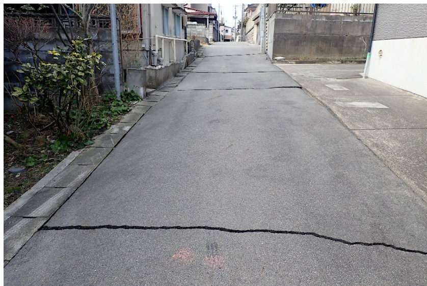
砂丘斜面の地すべり （側方流動）による 路面の横断亀裂
