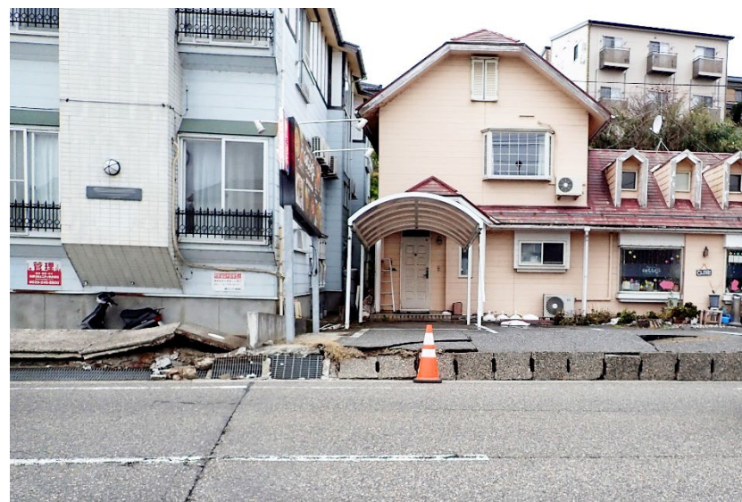
急傾斜の砂丘斜面のすべりによる宅地の隆起と建物の傾斜 宅地地盤内は液状化
