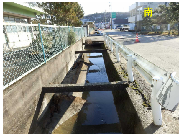
水路底盤のめくれ上がり （底盤の背後には砂がたまっている） 水路の梁の押し出し※あまり見ない現象
