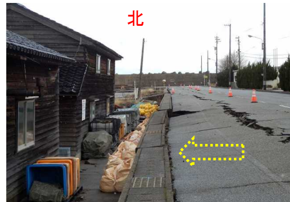
道路上に発達した直線状の亀裂（L=約300m） 海側（左側への押し出し）
