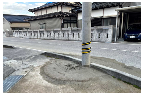
電柱の沈下と噴砂
