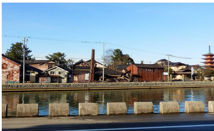
上庄川左岸 県道373号東側 旧醸造所の木造建物倒壊
