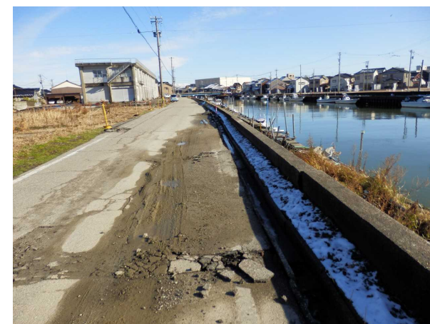
上庄川左岸沿いでの噴砂痕 および堤防の開き
