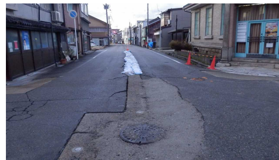
消雪装置の噴砂 痕(応急対応済)
