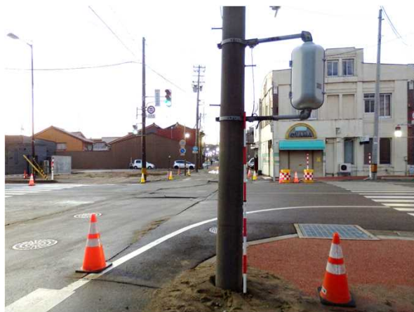
電柱の沈下
