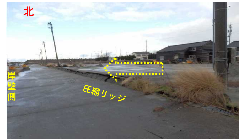
側方流動による圧縮 岸壁と作業場境界部における圧縮リッジ（右から左への押し出し）。作業場における著しい変状が無いいため、マスとしての動き
