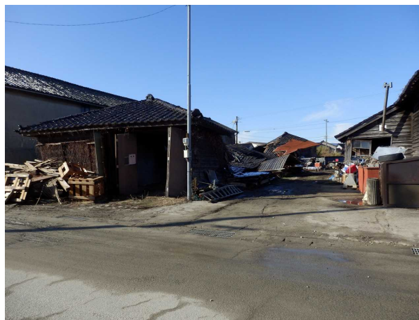
上庄川左岸 噴砂痕と木造倉庫倒壊
