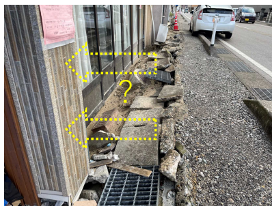
側溝の損傷・家屋の沈下
