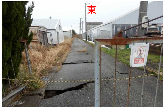
道路東側（右の写真）における亀裂群と不同沈下
